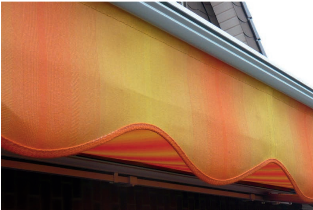
Image 9.1.19 Formation admissible de plis au niveau du volant dus à l'emballage
