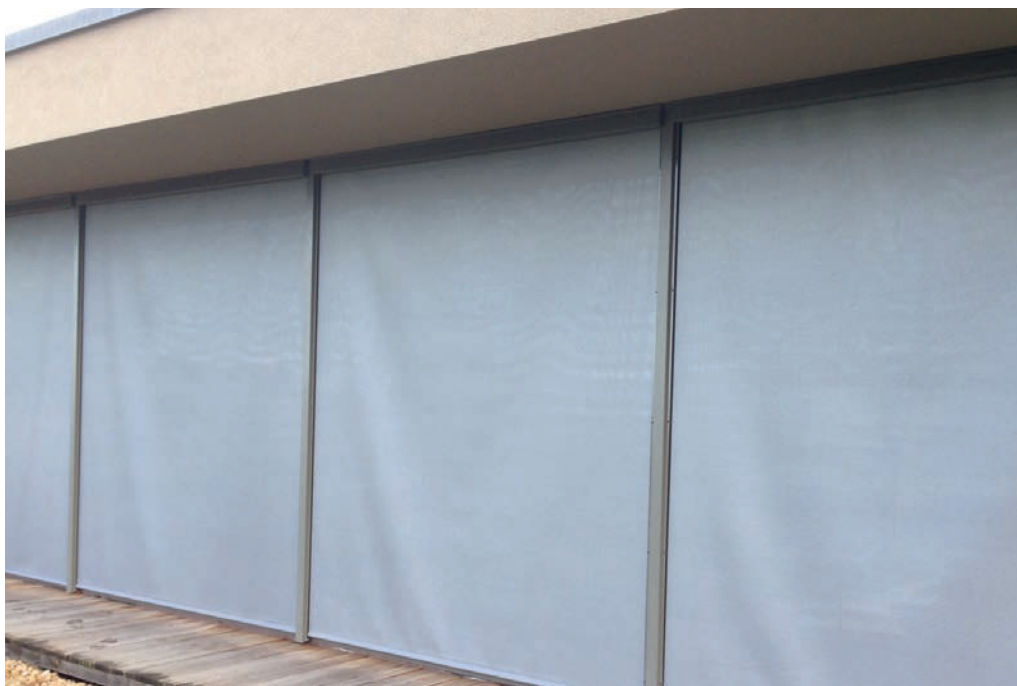
Image 9.4.8 Ondulations en V
