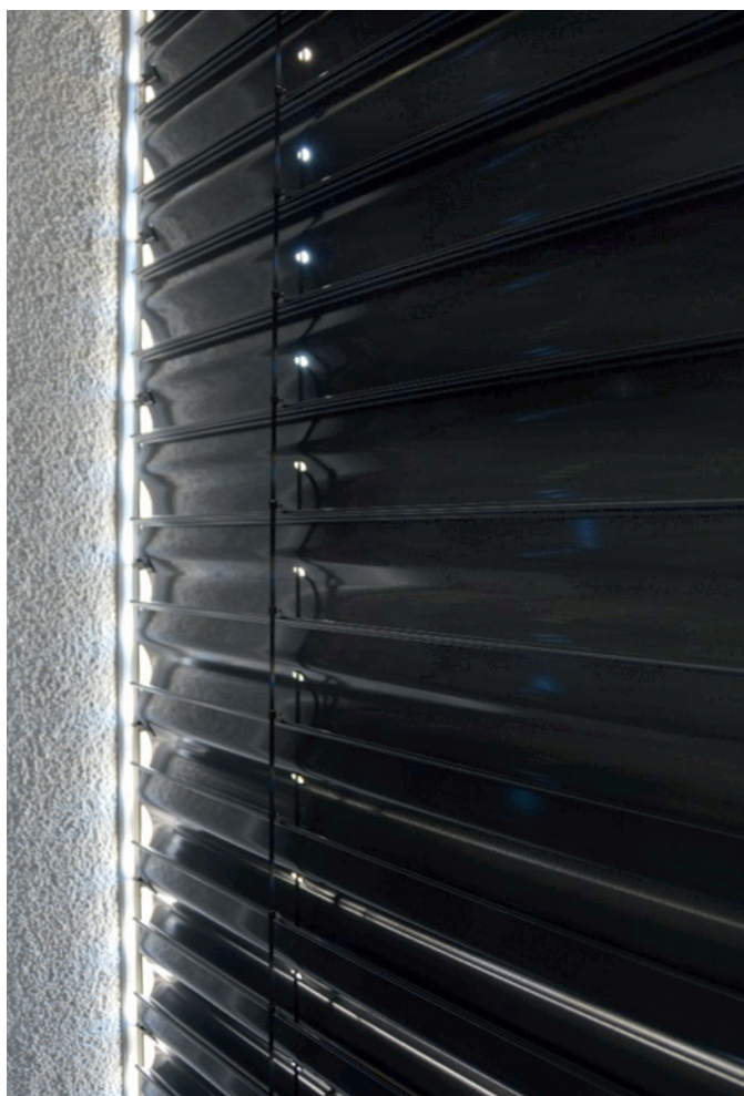
Bild 6: Zulässiger Streulichteinfall über die seitliche Führung
