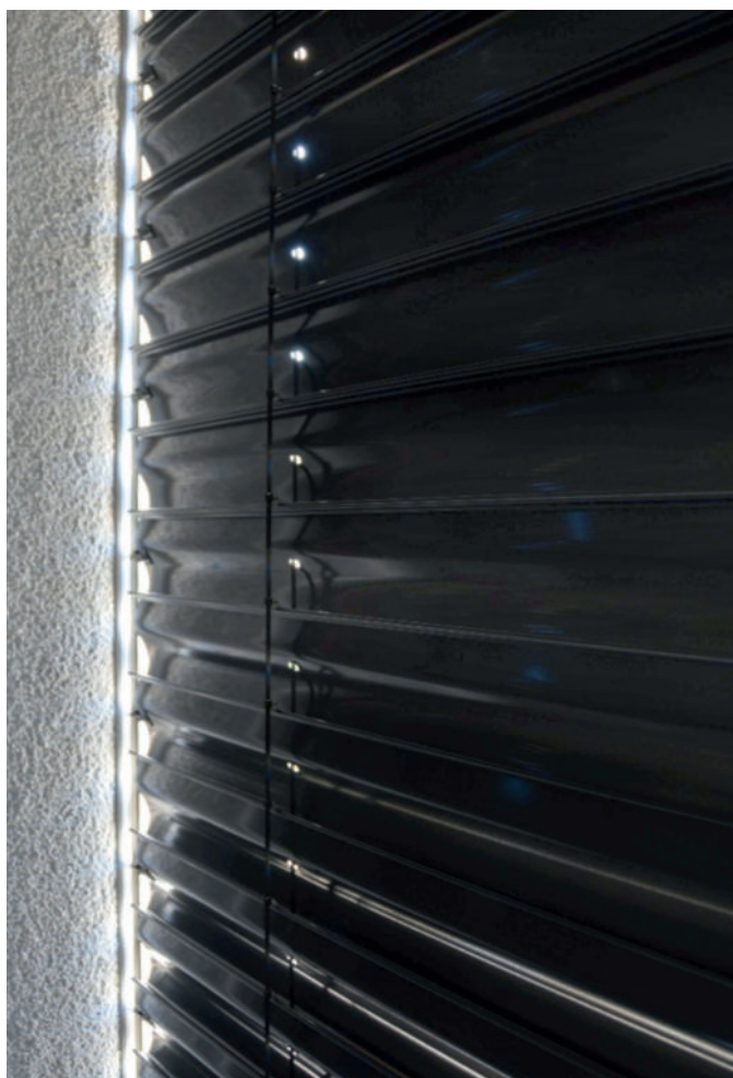
Bild 6: Zulässiger Streulichteinfall über die seitliche Führung
