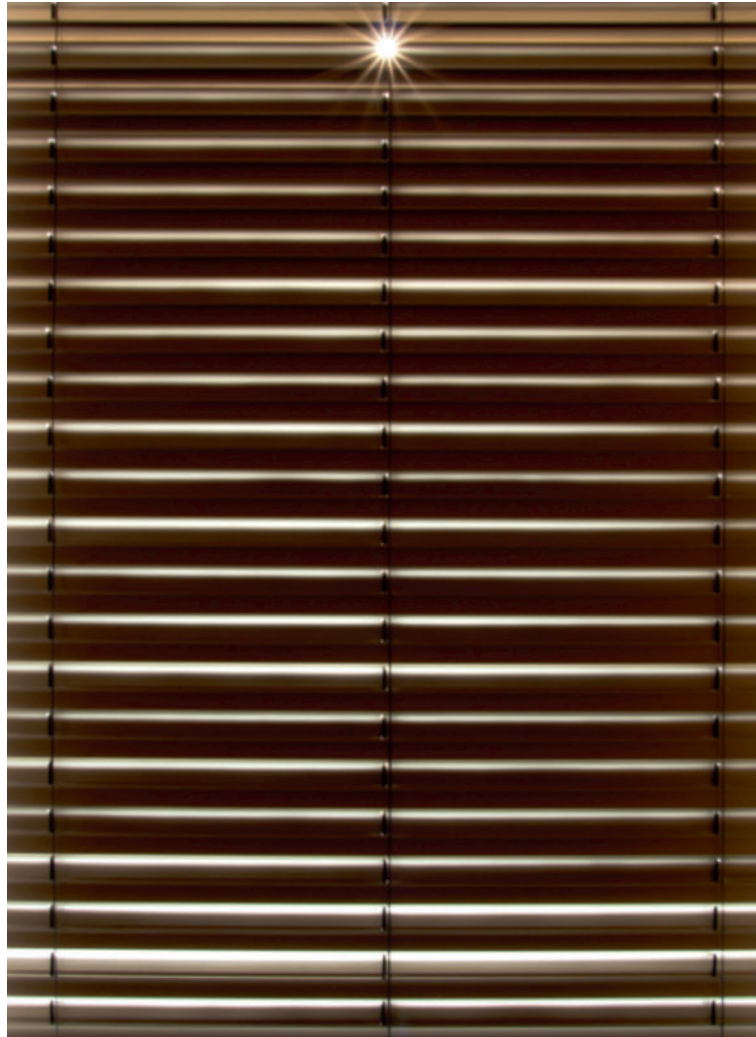
Bild 7: Variabler Streulichteintrag (Ansicht von innen)
